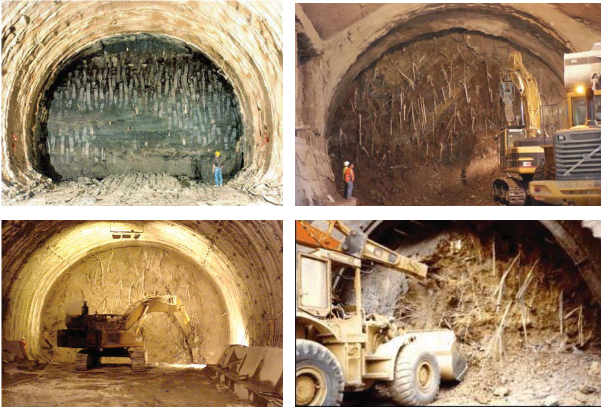
Figura 3 – Ejemplos de aplicación de las vidrioresinas (VTR) en la excavación de túneles en Europa y América
