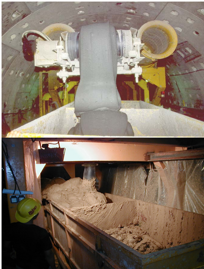
Figura 21. Ejemplos de terrenos excavados acondicionados.
