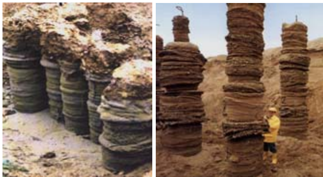
Figura 26. Columnas de jet grouting desenterradas.
