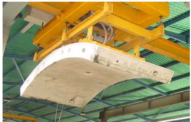
Figura 34. Movilización de los segmentos en la planta de prefabricación del Metro de Valencia en Venezuela.
