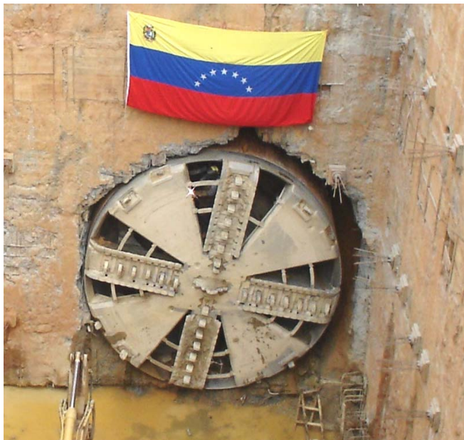
Figura 14. TBM de Escudo con cabeza giratoria sin frente de presión durante la construcción de un túnel del Metro de Caracas en terrenos de buena calidad.
