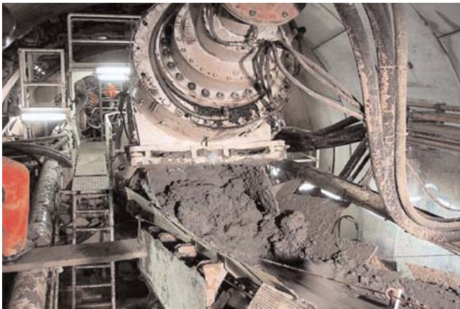
Figura 18. Cabeza superior del sinfín de extracción del material excavado y acondicionado en el Metro de Caracas.
