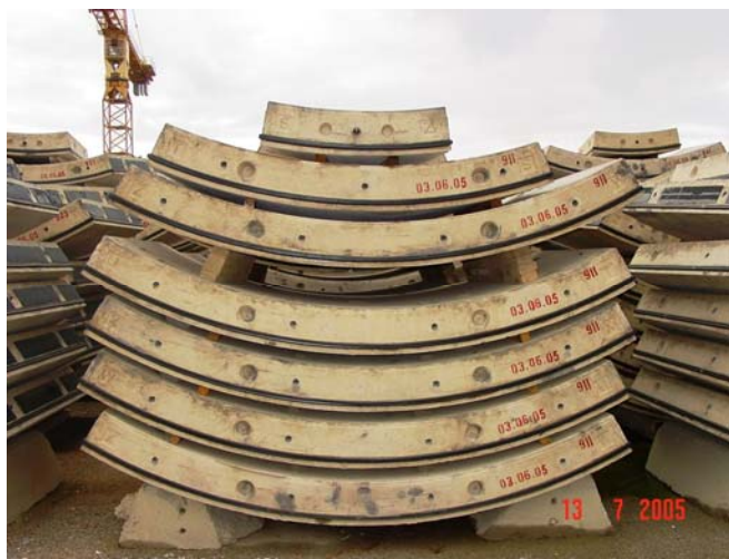
Figura 35. Apilamiento y almacenamiento de los segmentos
