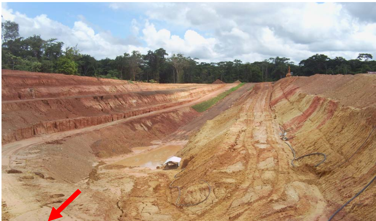
Figura 3 Box Cut del Acceso al Subterráneo
