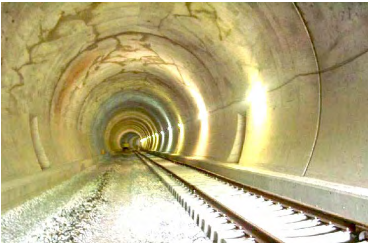
Ferrocarril Caracas-Cúa – Sección final de los túneles
