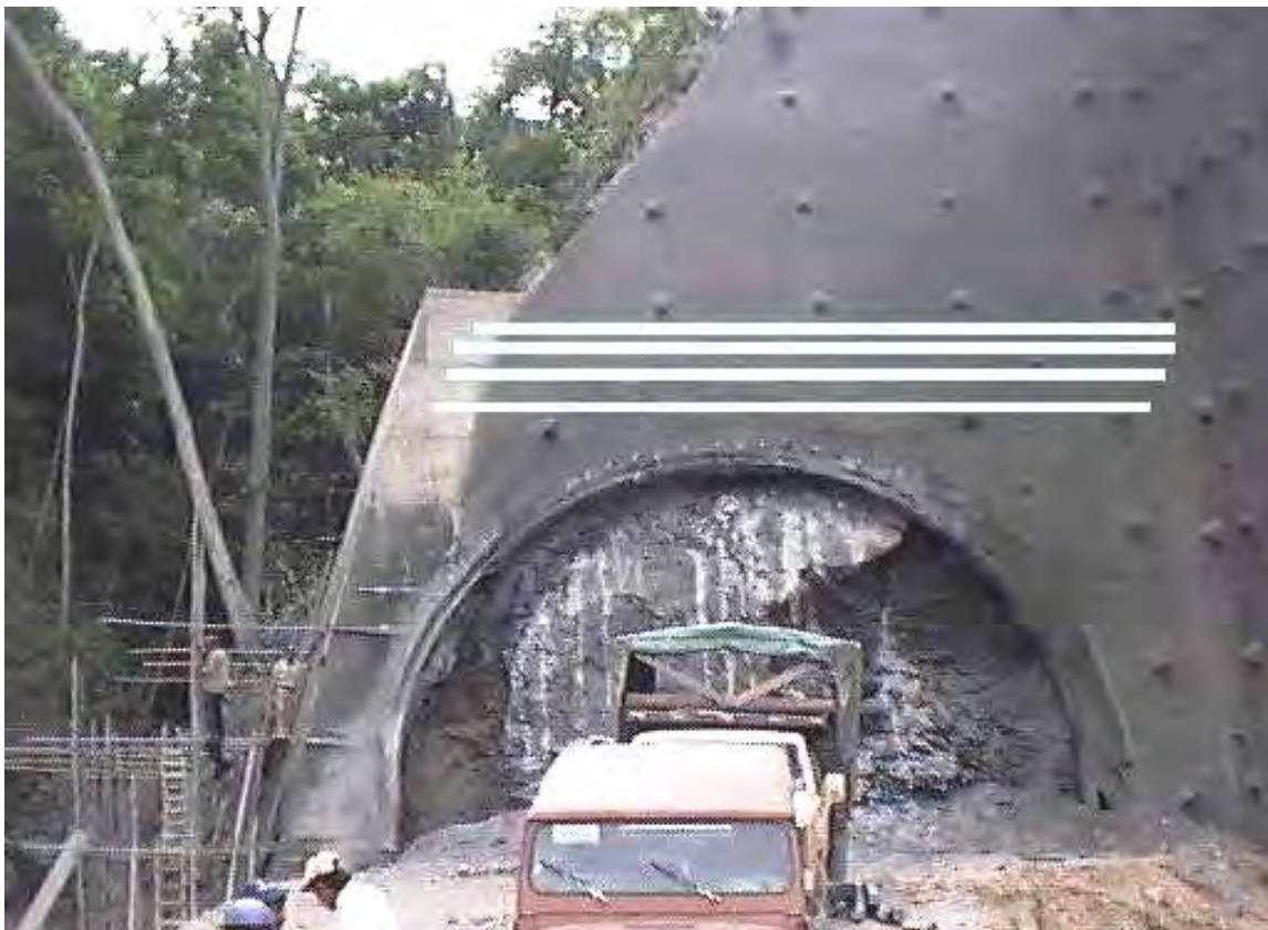
Ferrocarril Caracas-Cúa – Solución para un portal parietal en extremos
