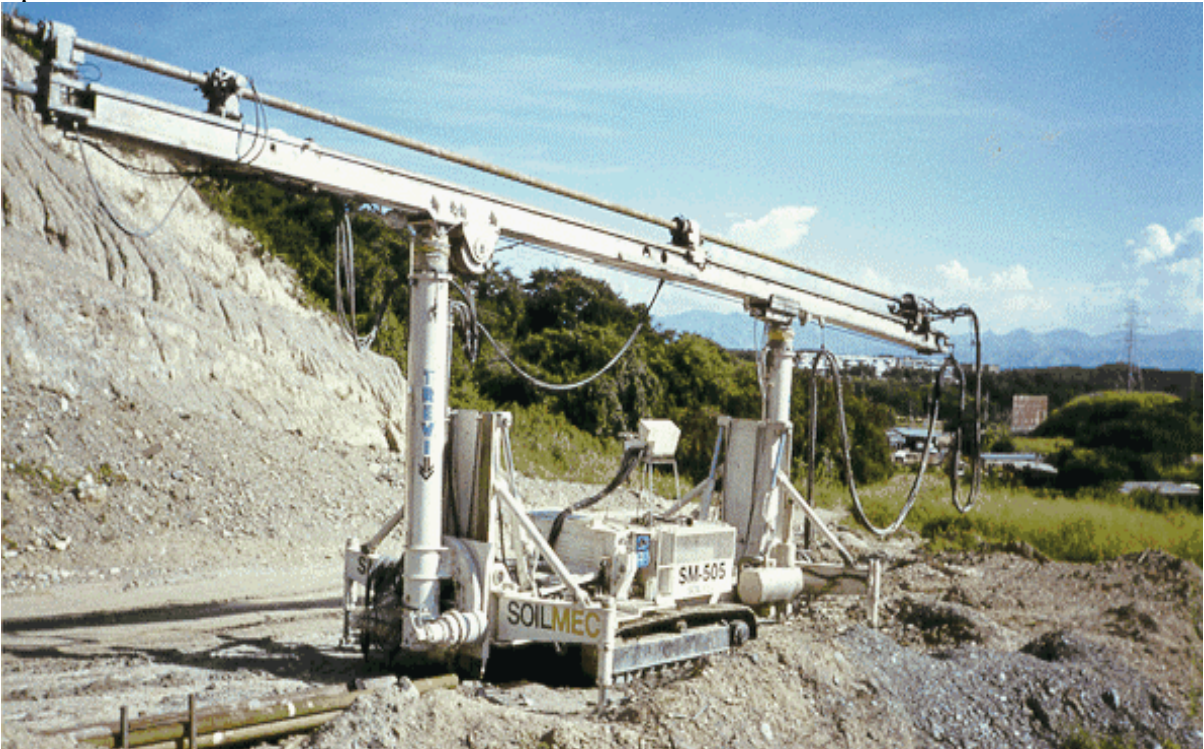
Ferrocarril Caracas-Cúa – Esquema y equipo para arco del pre-soporte de micropilotes
