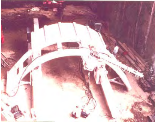
Metro de Caracas - Línea 2 - Túnel Minero: Equipos Sierra y Rozadora
