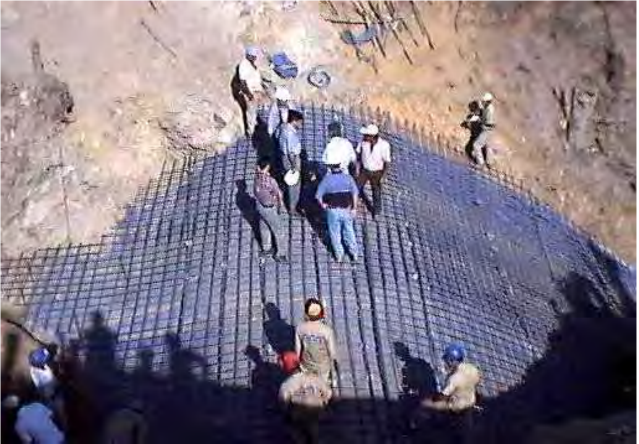
Ferrocarril Caracas-Cúa – Pre-bóveda para una sección sin cobertura
