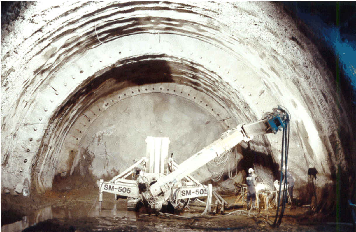
Ferrocarril Caracas-Cúa – Perforación del arco de micropilotes y elementos de vidrioresina
