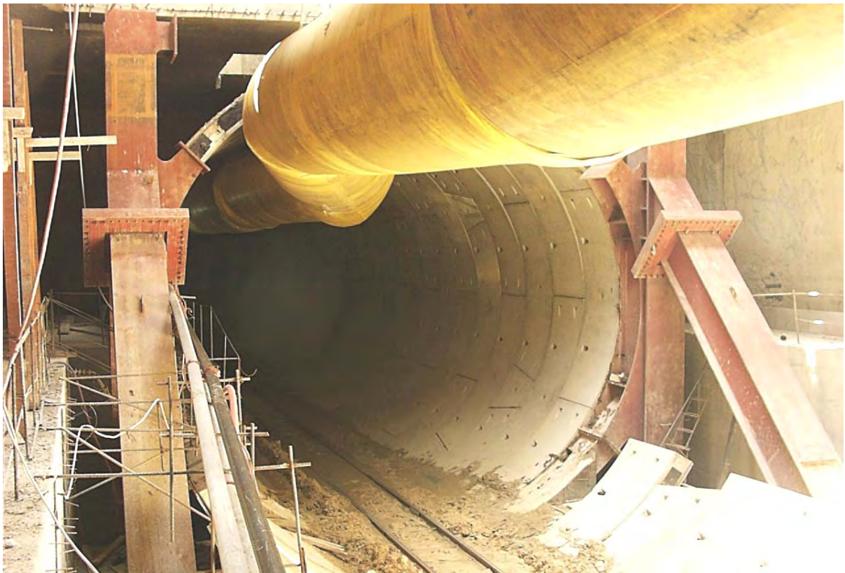
Metro de Valencia – Túnel revestido con anillos prefabricados universales
