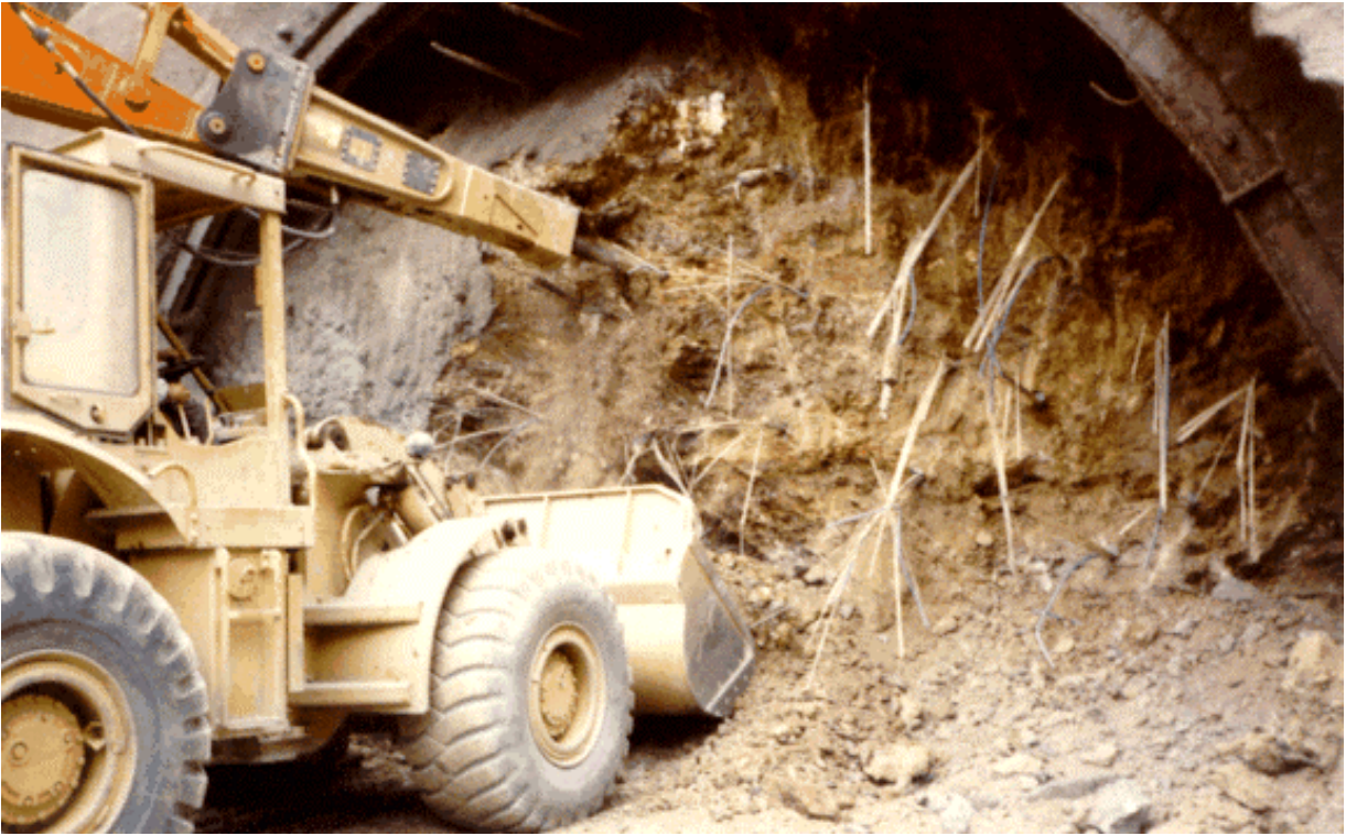
Ferrocarril Caracas-Cúa – Excavación de un frente reforzado con vidrioresinas
