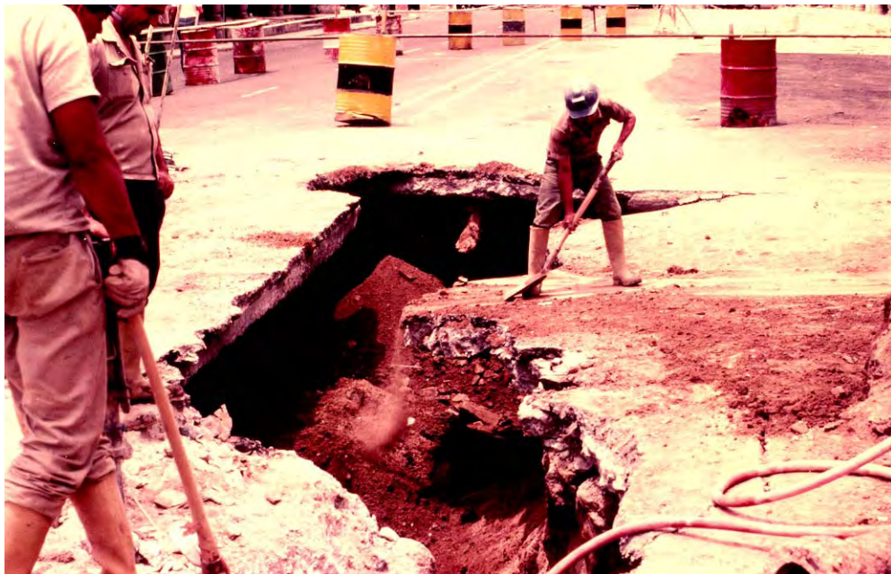
Metro de Caracas - Saneamiento de chimeneas hasta la superficie
