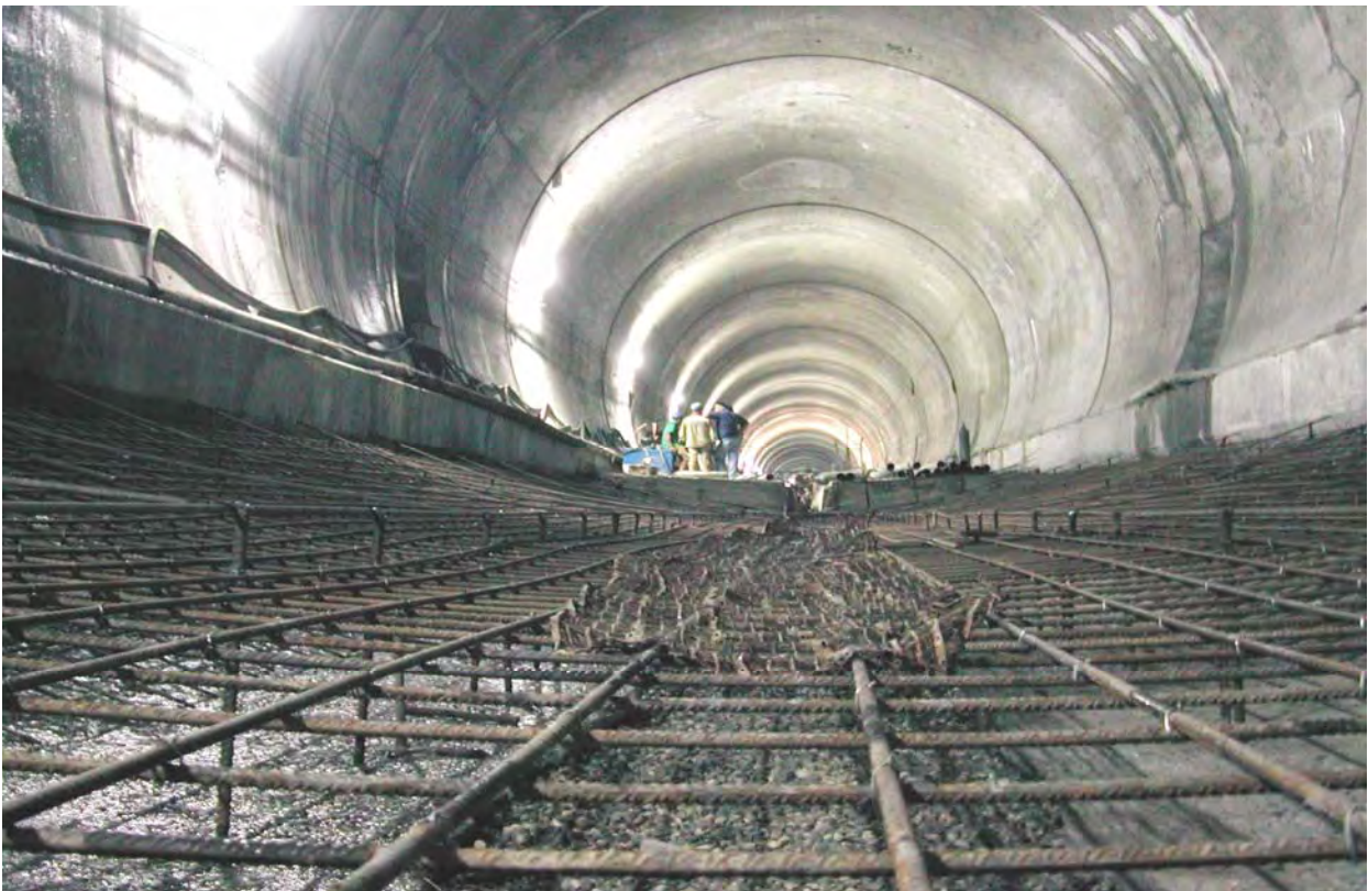
Ferrocarril Caracas-Cúa – Construcción del arco invertido del revestimiento
