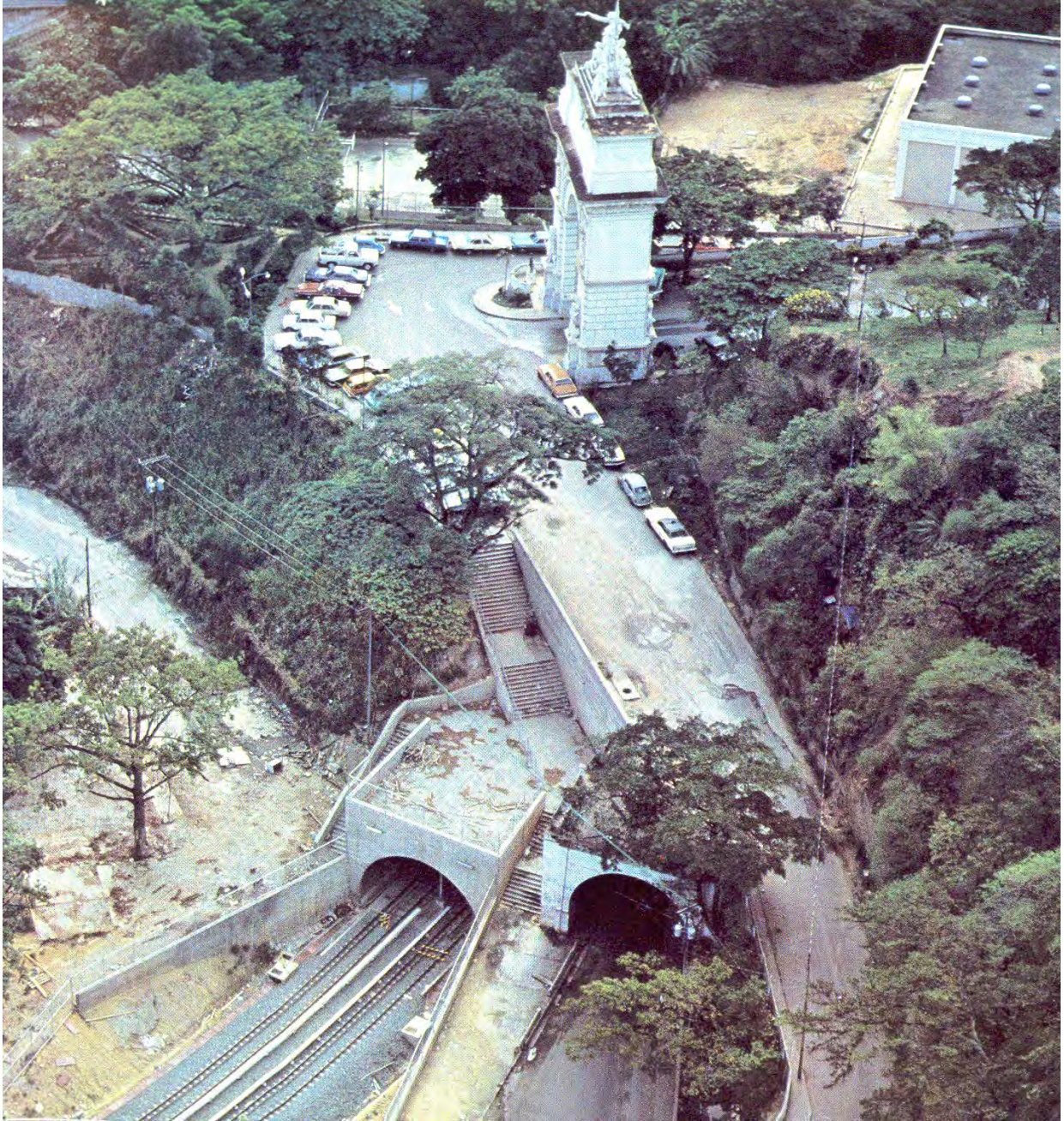
Pasado Remoto y Pasado Reciente: Túneles del Calvario y del Metro de C.en Caño Amarillo
