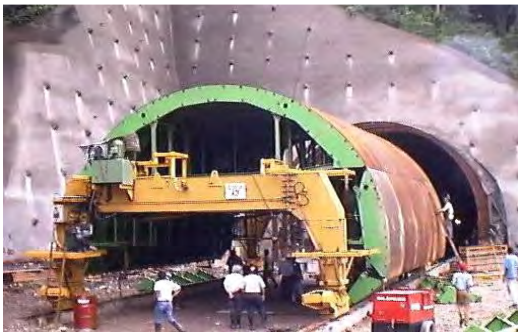
Ferrocarril Caracas-Cúa – Encofrado deslizante para el vaciado del revestimiento
