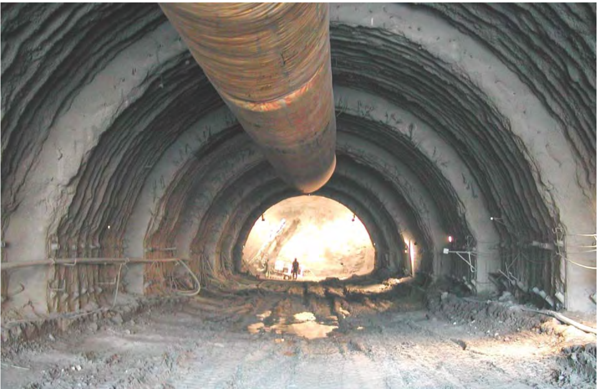
Ferrocarril Caracas-Cúa – Avance a media sección con arco troncocónico de pre-soporte
