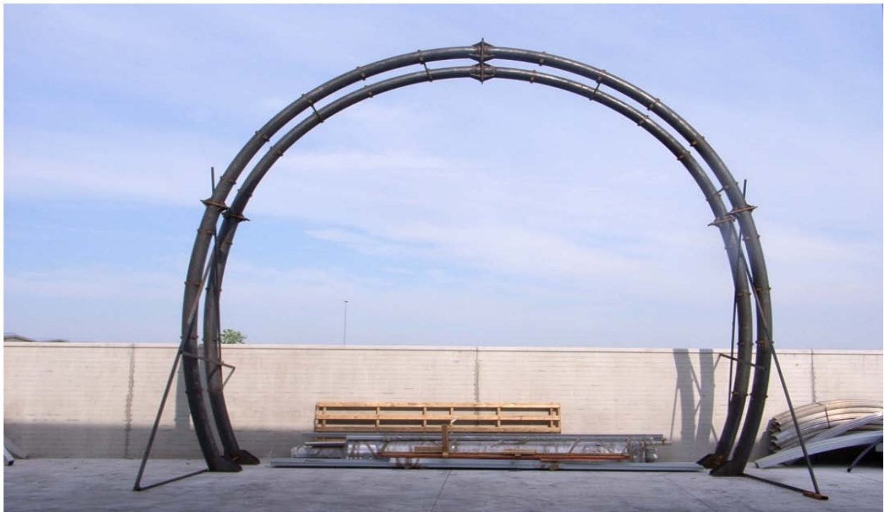
Figura 1: Configuración geométrica típica de dos marcos metálicos tubulares consecutivos
