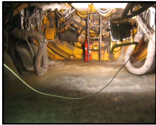
Figuras 9 y 10: Flujos de agua desde las fracturas y volúmenes de agua acumulados en el frente
