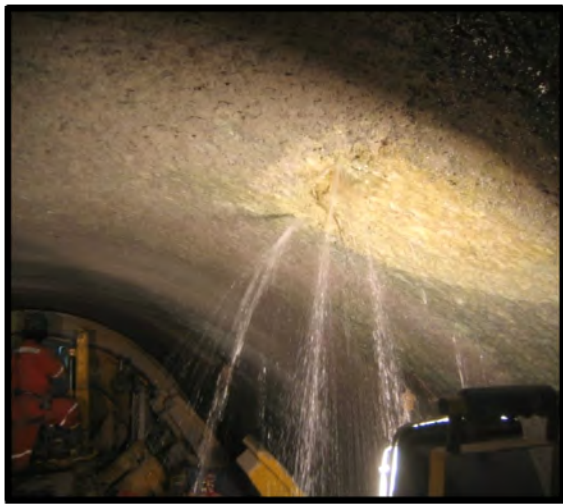
Figuras 9 y 10: Flujos de agua desde las fracturas y volúmenes de agua acumulados en el frente
