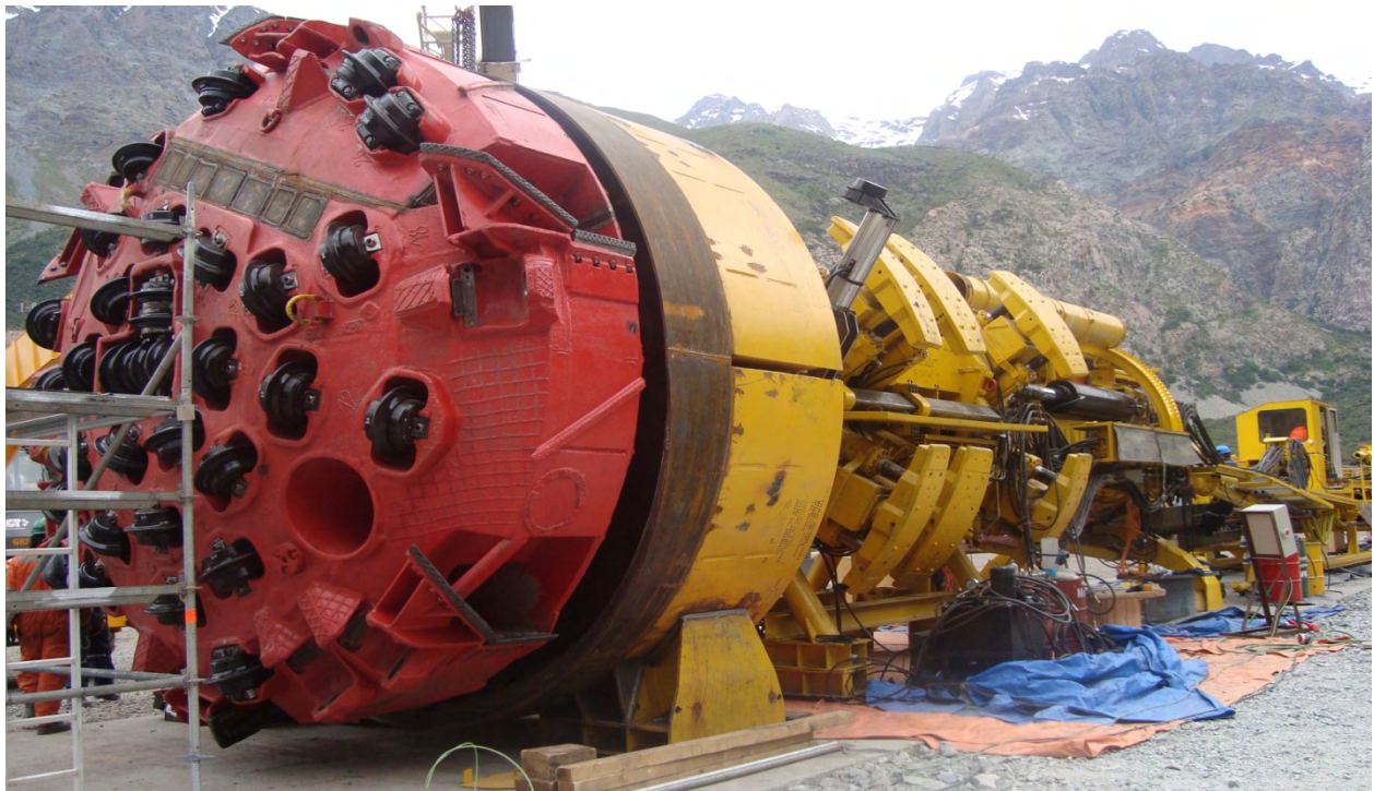
Figura 2: TBM WIRTH en fase de montaje al exterior del Portal de Salida del túnel Cipreses
